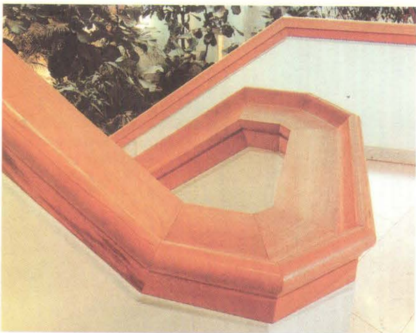
Деревянные перила лестницы в башне "Е"
