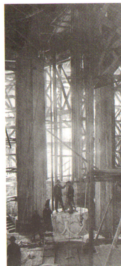
Установка капителей на колонны
