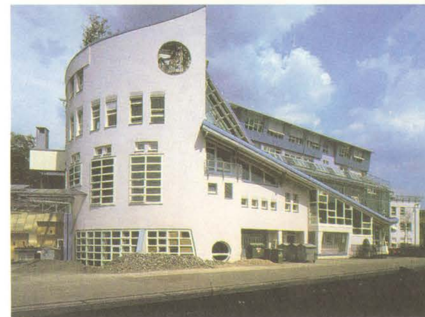
Экохауз. Северо-западный фасад
