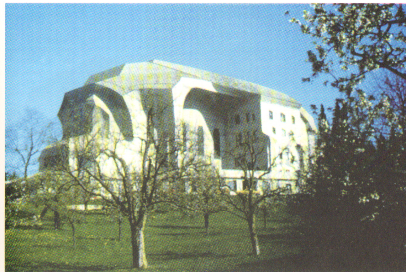
Вид с юго-запада
